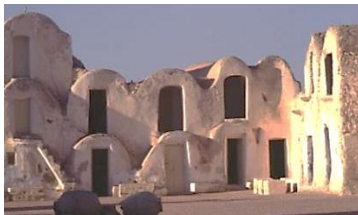
Sl.3.17 Kod berberskih gorfi (Medenine, Tunis), zasvođenih prostorija za skladištenje hrane, arhitektonska
