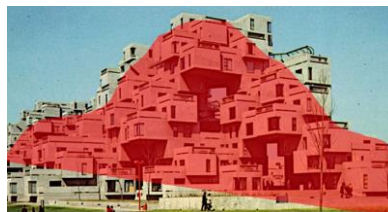
Sl.5.6 Tjelesnost stambenog naselja Habitat u Montrealu (arh. M. Safdie, 1967.g.,) jeste superstruktura koja nosi elemente slaganih armirano-betonskih ćelija i jednovremeno predstavlja formiranje pojedinačnog arhitektonskog objekta i njegovog konteksta u smislu naselja – grupe objekata unutar jednog formalnog obrasca. Tjelesnost te superstrukture vezana je za modele prirode – za formu „brda”, „planine”, i sl.
