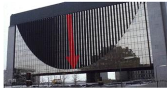
Sl.2.53 Građevina Federal Reserve Bank u Minneapolisu (Gunnar Birkerts Arch., 1973.g.) ima u formalnoj osnovi dvojni konstruktivni kôd formu moćnih bočnih stupaca i velike krovne grede te formu staklenog kubusa. Na staklenoj fasadi dominira polukružna forma okrenuta nadolje (poput forme obrnutog luka) koja izgleda kao da je
