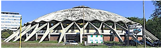
Sl.6.5 Osnovni arhitektonski, odnosno konstruktivni izraz Dvorane malih sportova u Rimu ( Palazzetto dello Sport , arh. Annibale Vitellozzi, inž. Pier L. Nervi, Rim, 1957.g.) zasnovan je na formama kupole (konstrukcija ljuske) i bočnih, zakošenih "Y" podupirača, koji, poredani u kružnu konstrukciju ostvaruju svojevrsan ornamentalni učinak. Tako, ova modernistička gradnja, bez imalo novih, ornamentalnih oblika koji bi bili pri-
