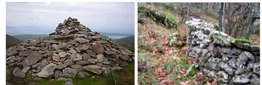
Sl.2.40 Uobrazilja koja je potrebna da bi se iz hrpe kamenja 69 konstruirala vertikalna forma zida vezana je za erekciju vertikale. Kod prvih konstrukcija
