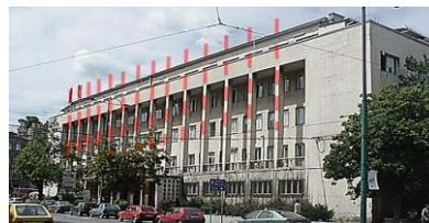
Sl.2.18 Zgrada Higijenskog zavoda u Sarajevu (1951.g.) izgrađena je u maniri socijalističkog realizma, sa evidentno neoklasicističkim arhitektonskim kodom zasnovanim na izrazu stuba i grede 51 . Ali, budući da centar objekta, odnosno
