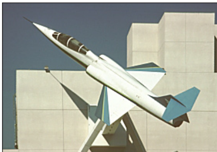
139. Jedan od savremenih primjera prenošenja značenja sa starih na nove elemente unutar arhitekture kuće - California Aerospace Museum (arh. Frank O’Gehry, realizacija 1982.-1984. g.). Arhitektonski element krova zamijenjen je novom arhitektonikom - objektom aviona. Ali, održan je metafizički učinak elementa Neba koje i krov i avion artikuliraju. Avion se samo javlja kao savremenija interpretacija elementa Neba, ali metafizički nebeski učinak krova ostaje.
