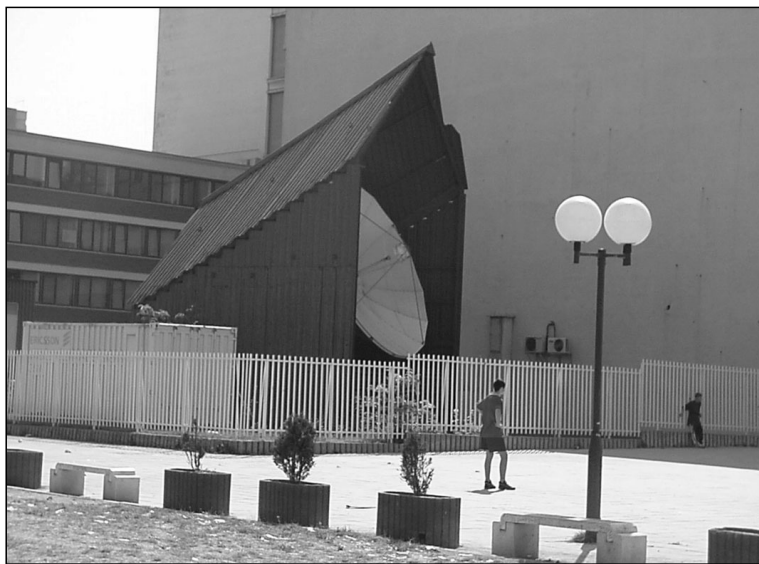
9d. Arhitektura prvobitne kolibe u naglašenom izdanju metafizike i arhitekture elementa Neba kroz karaktere neboorijentiranosti, vertikalnosti, "transcendencije značenja" satelitske antene itd., skrivena je u pomoćnom objektu gradske pošte. (Centralna pošta u Sarajevu)
