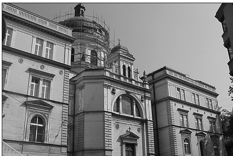
14d. Renesansni ustroj Albertijeve kompozicije tačno određenih odnosa dijelova i cijeline ne trpi naknadna oduzimanja i dodavanja. Intervencije dodavanja na samo jednom krilu objekta simetrične kompozicije pročelja nedopustivost takve intervencije snažno pojačavaju. (Nadbiskupsko sjemenište i Crkva Ćirila i Metodija u Sarajevu)
